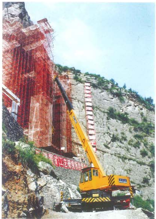
链子崖危岩体防治工程
