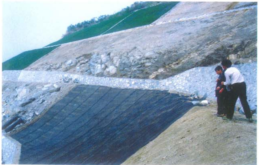
施工区边坡绿化
