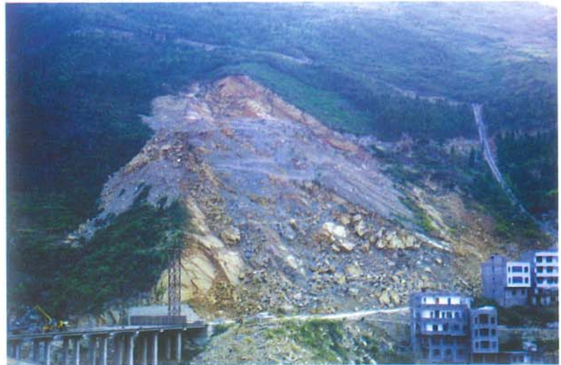
湖北巴东县白岩沟西侧滑坡(1998年6月29日发生)
