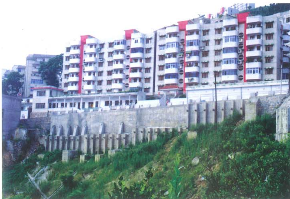
湖北省巴东县二道沟滑坡治理后
