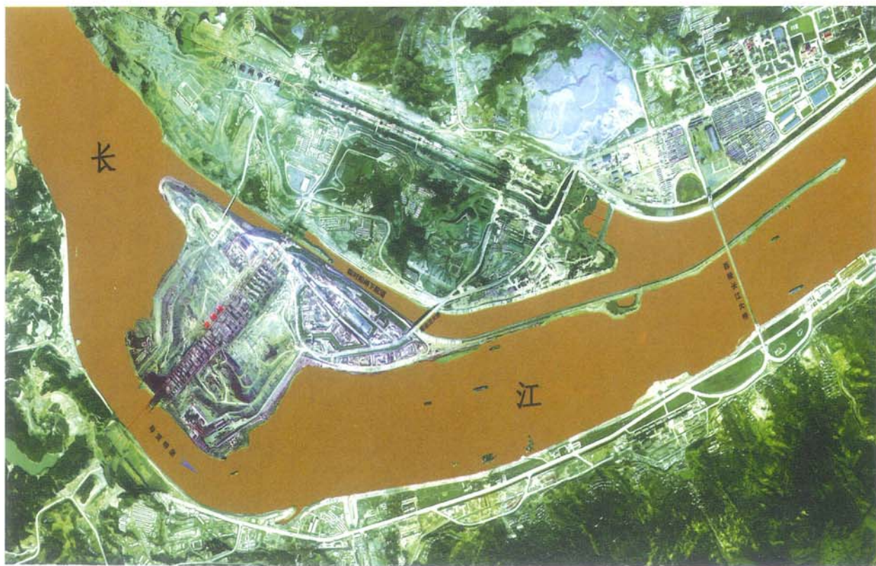
三峡坝区影像图(1999年10月航空摄影)
