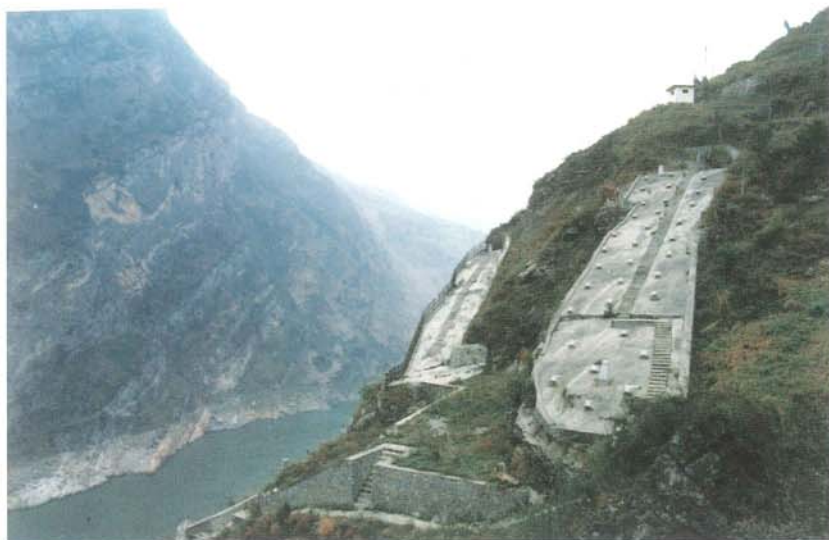
链子崖危岩体顺层滑移体锚固工程
