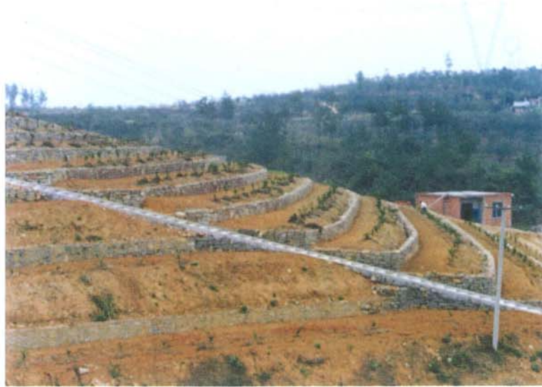
湖北省宜昌县长青岗村“坡改梯”工程
