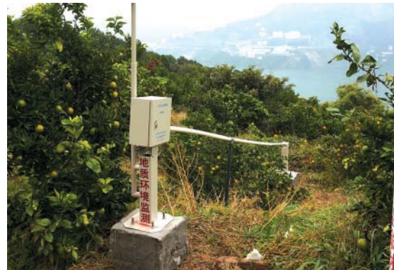
滑坡地表裂缝自动化监测
