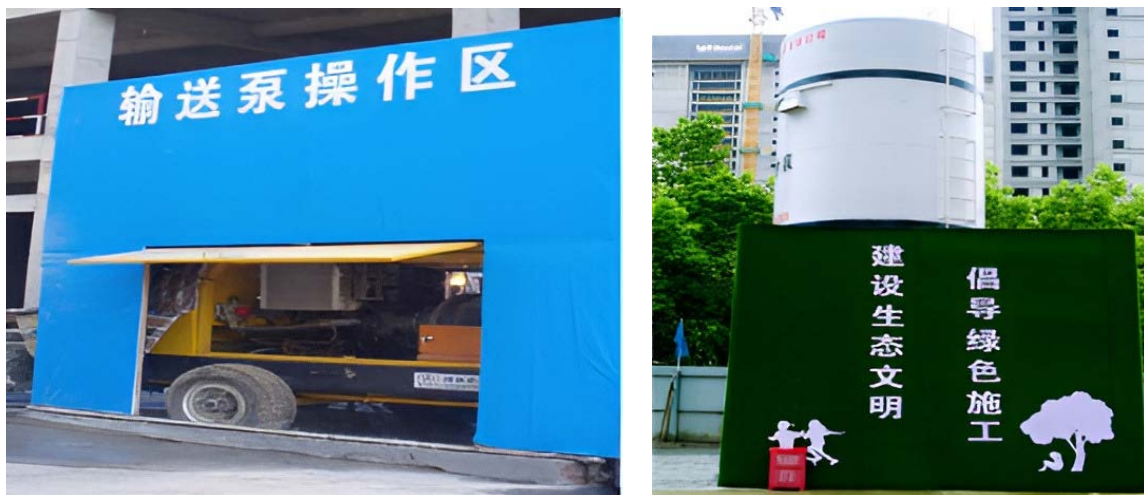
图 3-2 浙江省温州市某工地混凝土输送泵和砂浆罐降噪棚
